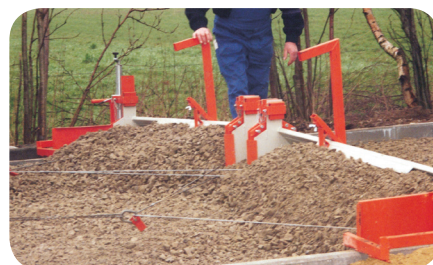
Schotter-Einbau bei einer Fahrstraße mit mittlerer Überhöhung (Dachprofil)
