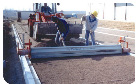
Höhenverstellbare Laufwerke im Einsatz über Bordsteinkante u. Niveau-Schienen
