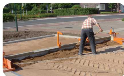
5,5 Meter werden passgenau zwischen Rinne und Bord abgezogen
