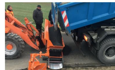
Die Schaufel wird direkt vom LKW befüllt.
