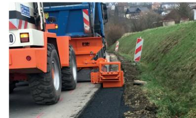
Materialverteilung: Abziehen mit Stahlschild
