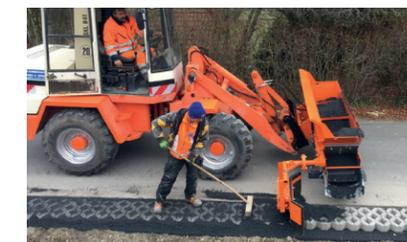
Rasengitter-Steine füllen mit Gummischild
