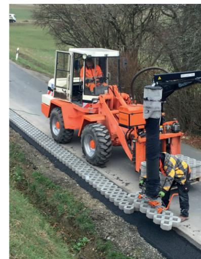
Verlegung Rasengitter-Steine mit Optimas-Vacu-Lift
